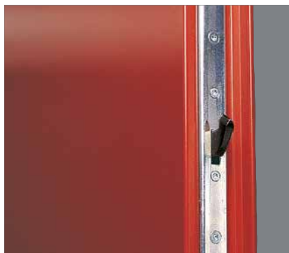
Säkerhetsdörr S43 har ett flerpunktslås där huvudlåset kompletteras med hakreglar upp- och nedtil.
